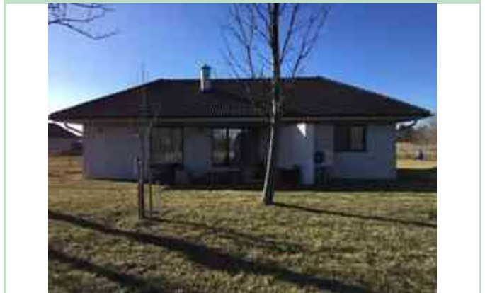
Megjegyzés: Keleti homlokzat
