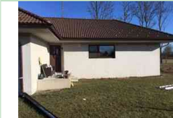
Megjegyzés: Nyugati homlokzat
