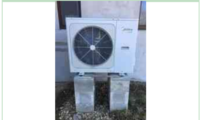
Megjegyzés: Hőszivattyús fűtési rendszer
